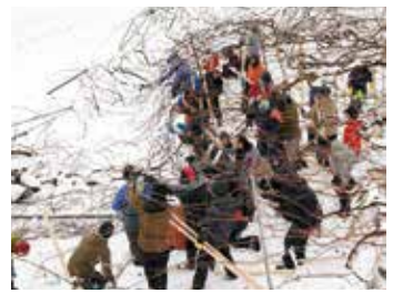
科野地区での雪害復旧作業
