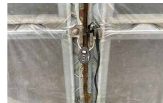
写真① 出入口をしっかりと施錠する
